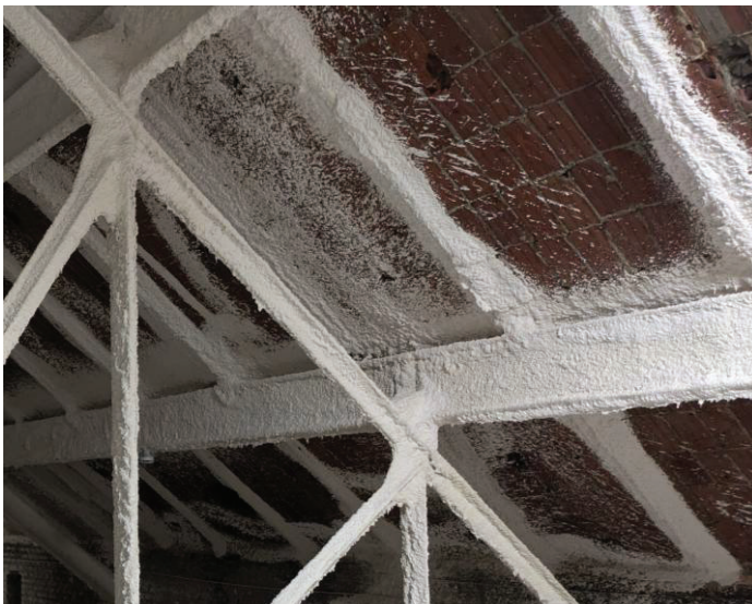
Detalle de zona con revestimiento interior de rasilla cerámica
