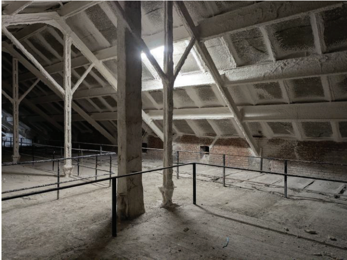
Espacio de bajocubierta. Estructura metálica protegida con vermiculita proyectada. Revestimiento interior con planchas de fibrocemento con amianto.
