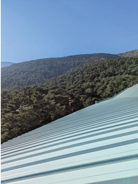
Revestimiento exterior de chapa grecada galvanizada
