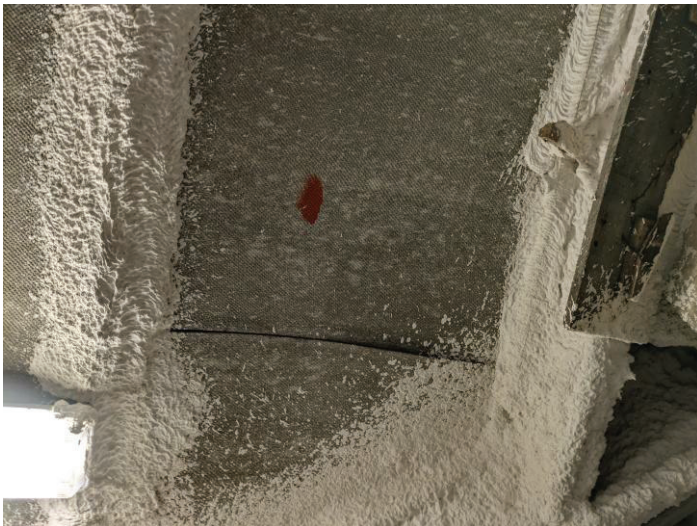
Detalle de zona con revestimiento interior de planchas de fibrocemento con amianto
