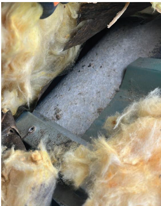
Composición interior de cubierta. Lana de roca anclada con perfiles omega a plancha de fibrocemento con amianto. Chapa grecada galvanizada para remates y aleros
